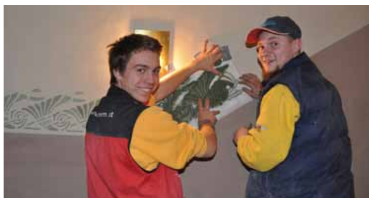
Zwei Profis der Firma Karl Christanell bei der Arbeit. Die Wände erhalten wieder den originalen Anstrich.
